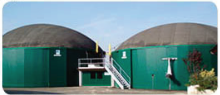
● Depósitos bio-digestor
