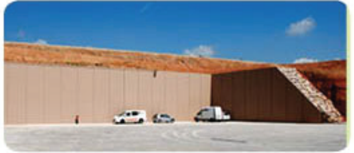
● Muros de contención
